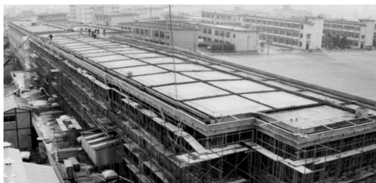
機械科棟の増築工事 昭和五十六年二月十六日撮影
